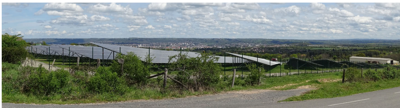
Parc photovoltaïque à Quinssaines, impactant fortement le point de vue
