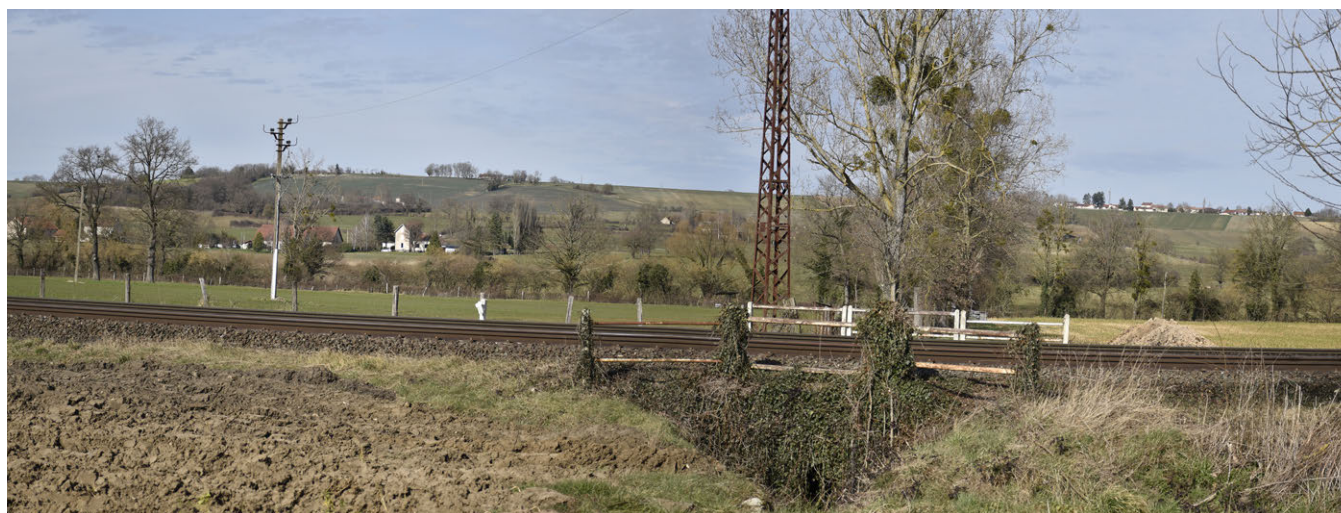
Ligne ferroviaire entre Seuillet et Magnet
