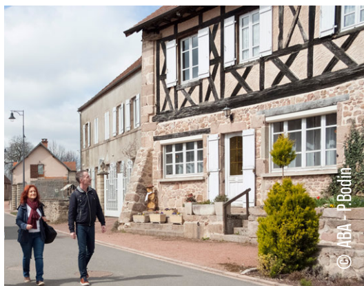
Maison à pan de bois à Droiturier
