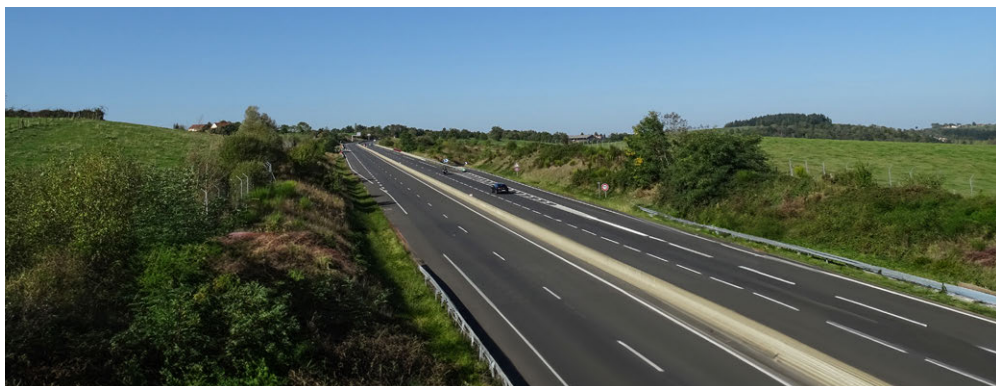
Nouvelle RN7 à 2x2 voies à Droiturier
