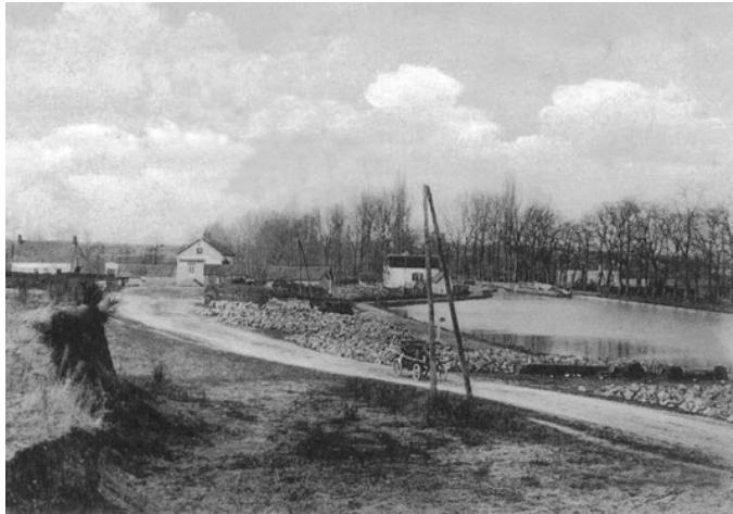
Travaux du port à Gannay-sur-Loire (delcampe.net)
