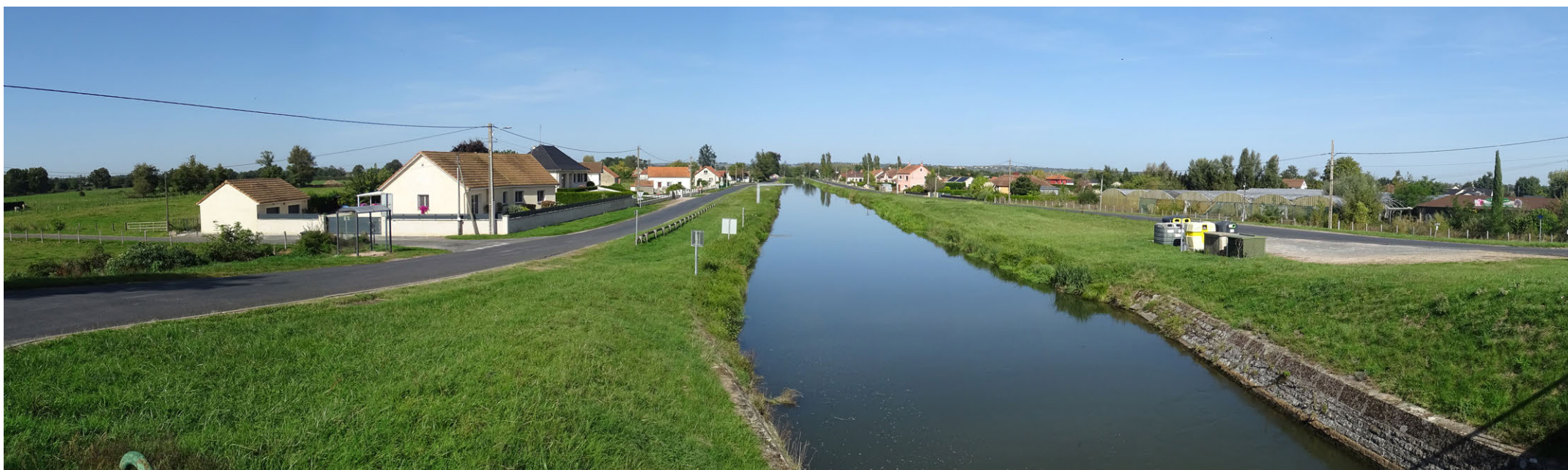
Urbanisation installée en bord du canal de Roanne à Chassenard
