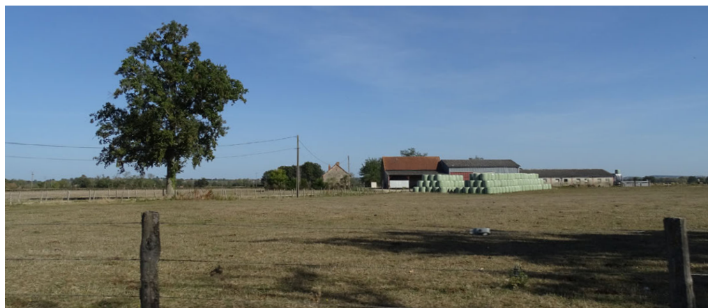
Groupement bâti agricole mêlant bâtiments anciens et récents à Garnat-sur-Engièvre
