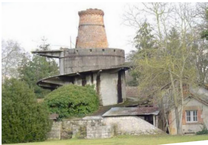
Four à Chaux à Diou (Allier-hotels-restaurants.com)
