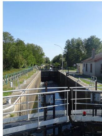
Ecluse et maison à Diou
