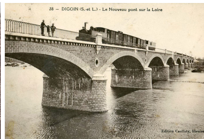
Pont ferroviaire sur la Loire à Digoins (delcampe.net)
