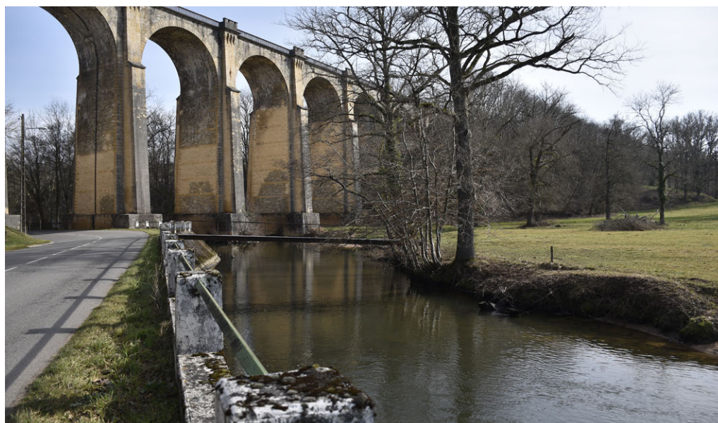
Viaduc ferroviaire de Lapalisse depuis la D7 à Saint-Prix, franchissant la Besbre
