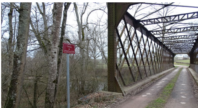
Chemin du pont de fer entre Trézelles et Varennes-sur-Tèche : ancienne ligne du « Tacot »
