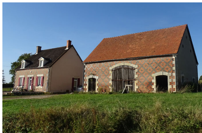
Ferme en brique polychromique vers Neuilly-le-Réal
