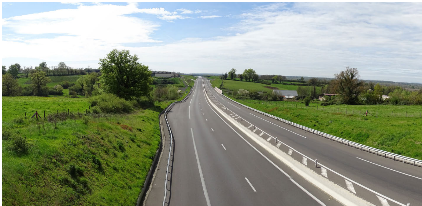
La RN7, en limite ouest de l'ensemble, vers Villeneuve-sur-Allier
