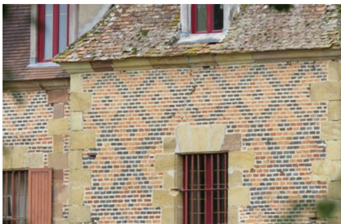
Façade en briques polychromes du château de la Fin à Thiel-sur-Acolin
