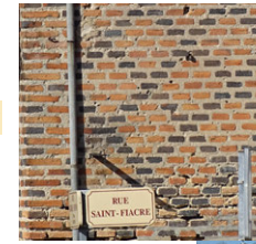
Façade en brique polychrome à Paray-le-Frésil
