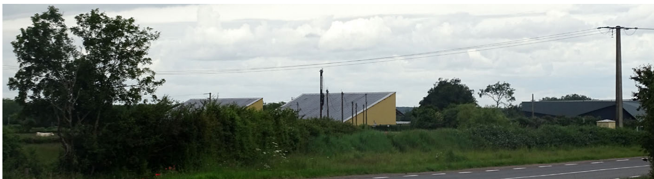
Bâti agricole récent avec toiture photovoltaïque à Yzeure
