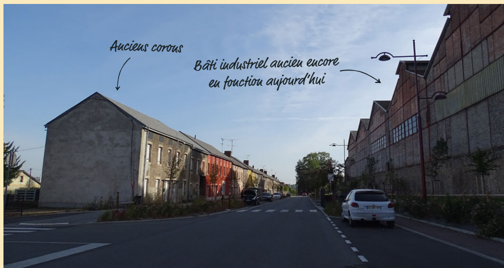
Quartier industriel ancien à Commentry
