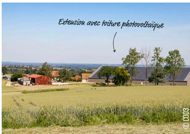
Bâtiment agricole récent à Noyant-d'Allier
