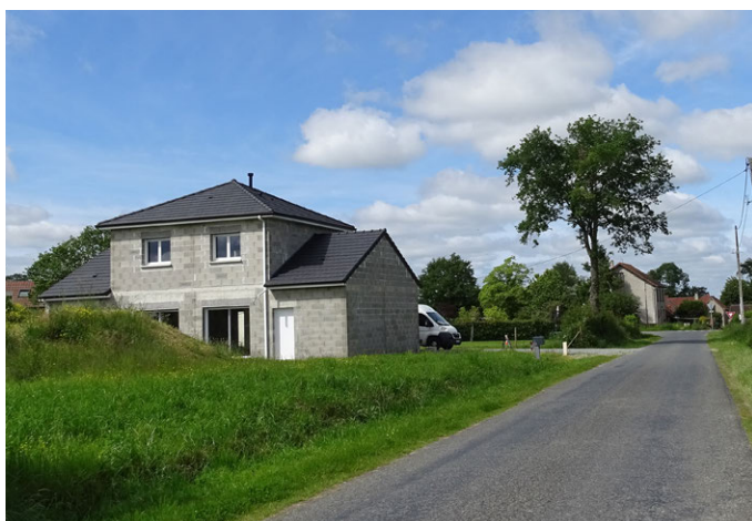
Nouvelle construction résidentielle près de Sauvagny
