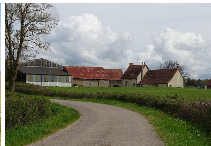
Bâtiments agricoles de différentes époques vers Cosne-d'Allier
