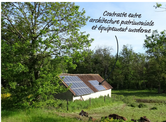
Habitation rurale à Saint-Hilaire, équipée de panneaux photovoltaïques
