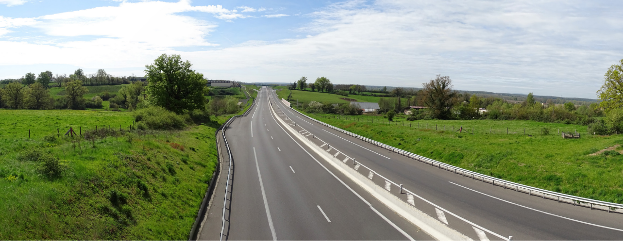
RN7 élargie à 2X2 voies vers Villeneuve-sur-Allier (Val d'Allier)
