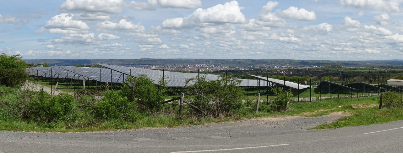
Parc photovoltaïque à Quinsaines (Bocage)
