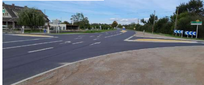
Retraitement de chaussée sur nos RD
