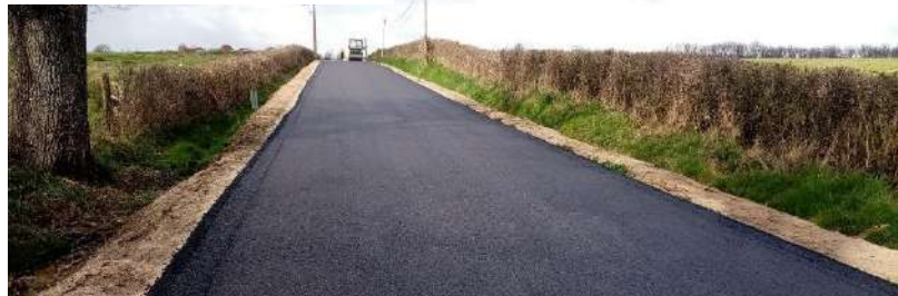
Travaux accès Le Pal
