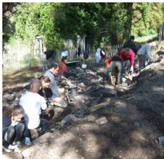
Le Département organise des chantiers de restauration participatifs.
