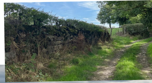
Muret en pierre sèche à Marcillat-en-Combraille
