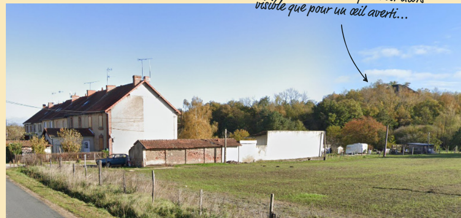
Bâtiment et terril, rares témoins de l'activité minière passée au lieu-dit des Ferrières
