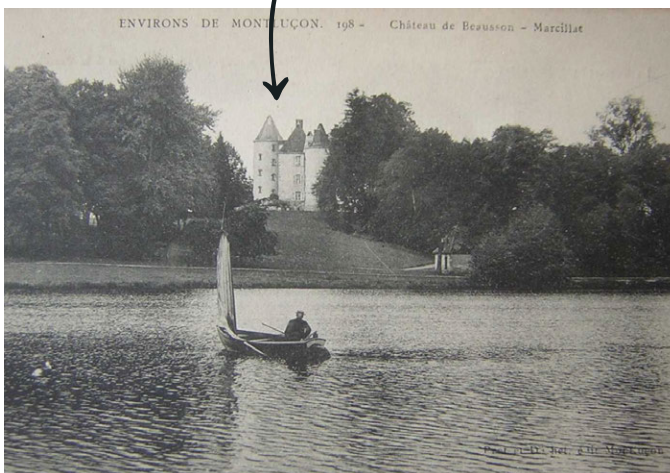
Château de Beausson à Terjat (archives départementales)
