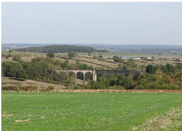
Viaduc du Bellon à Coutansouze
