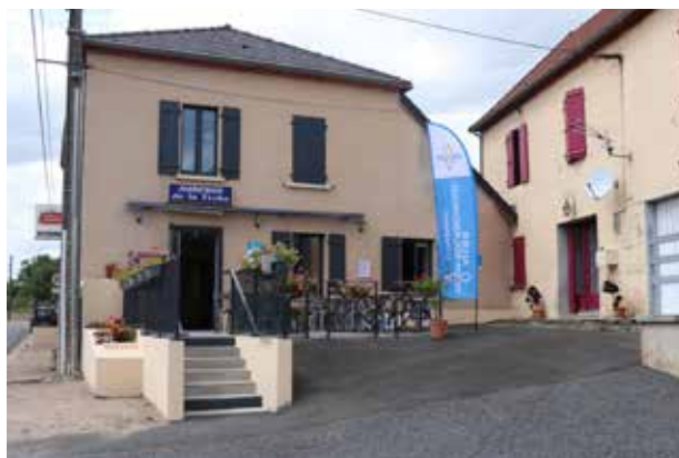
Réhabilitation de l'auberge de Varennes-sur-Tèche
